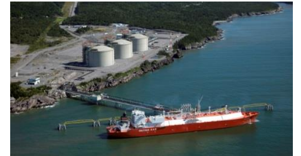
Saint John LNG (Repsol Energy North America)
