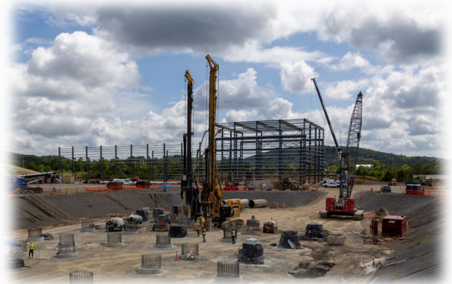
Kairos Hermes – first concrete pour in Tennessee
